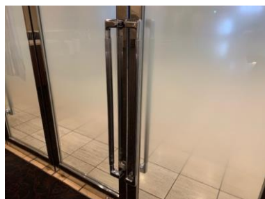
出入口ガラス扉手摺
