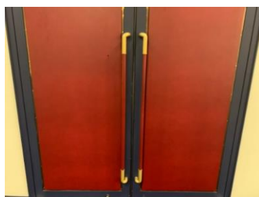
ホール出入口扉手摺
