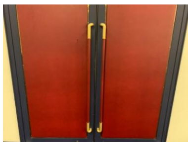
ホール出入口扉手摺
