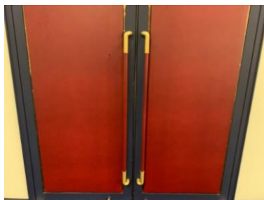
ホール出入口扉手摺
