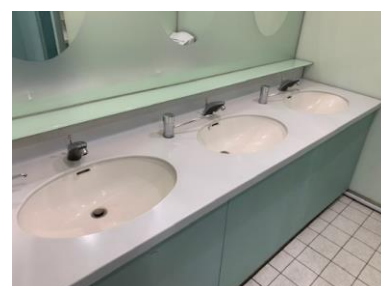
【トイレ洗面台】
