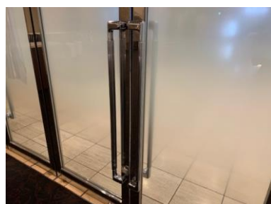
出入口ガラス扉手摺
