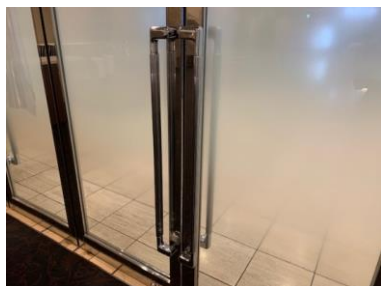
出入口ガラス扉手摺
